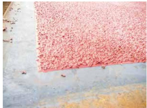
3~5mmのセラミック骨材のため滑り止め効果は
