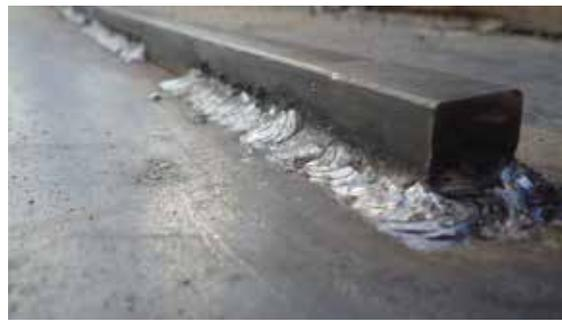
溶接は5.5cm間隔で堅固に行い、剥れにくい構造です。
