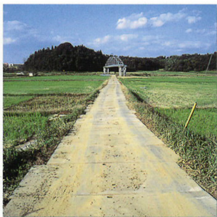
施工例 軟弱地盤上の重機搬入路確保
